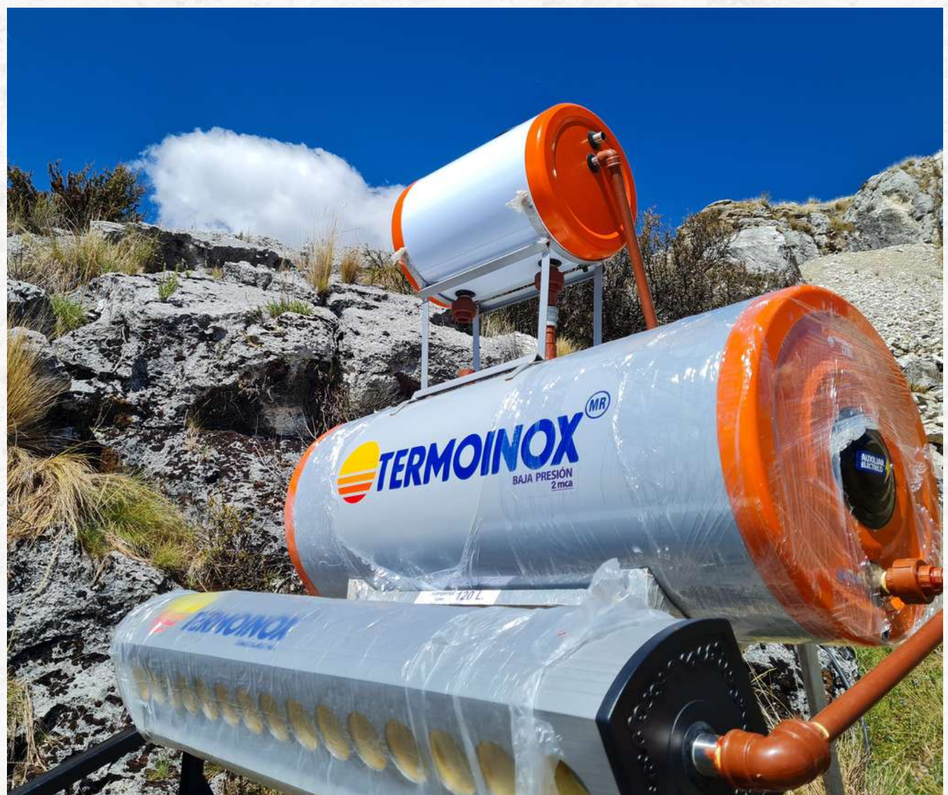
Terma solar en proceso de instalación
